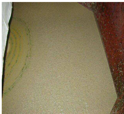
破碎終了後（1次タンク内）
