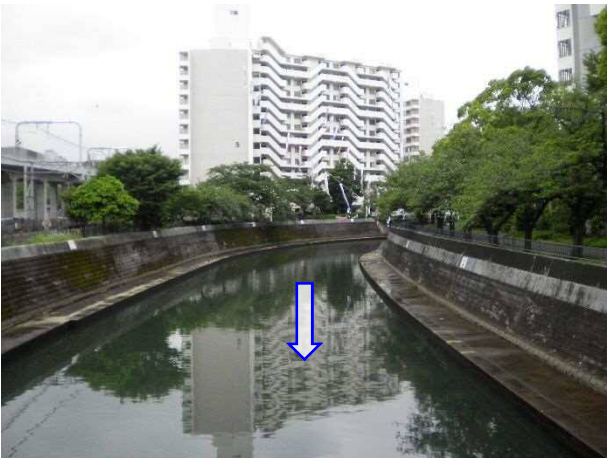
整備済み箇所（古町橋付近）
