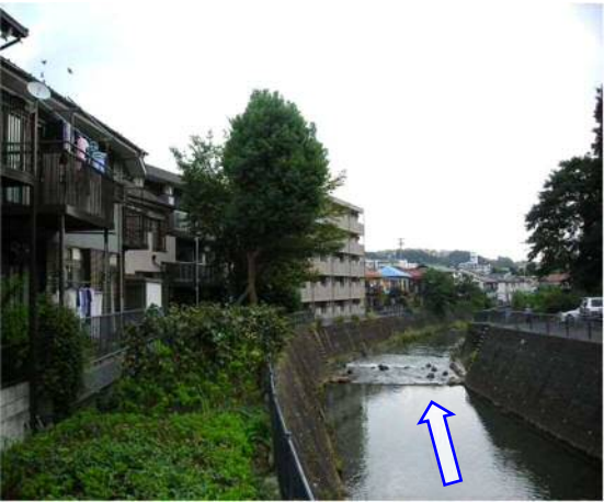
整備予定箇所（学校橋付近）
