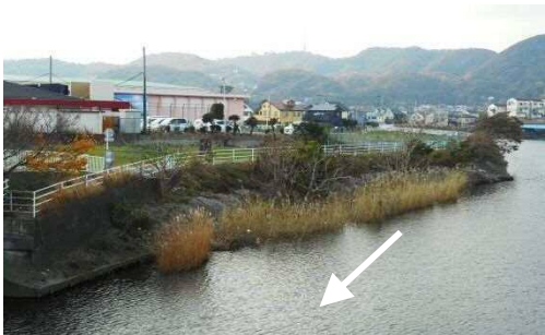
花水川橋上流右岸（未整備箇所）
