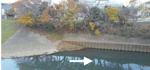
平塚橋上流左岸（未整備箇所）
