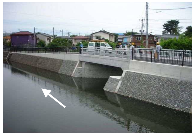
環境型ブロックを使用した護岸
