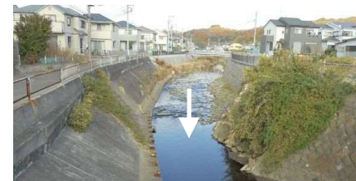
国府橋上流（未整備区間）
