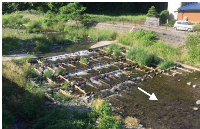
スロープ型落差工
