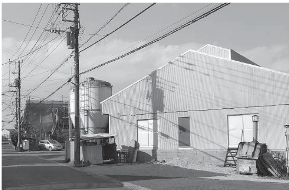
[県内市街化区域内の農業用施設（鶏舎）の状況]
