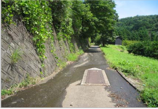
雨水を流下させる水路兼用農道
