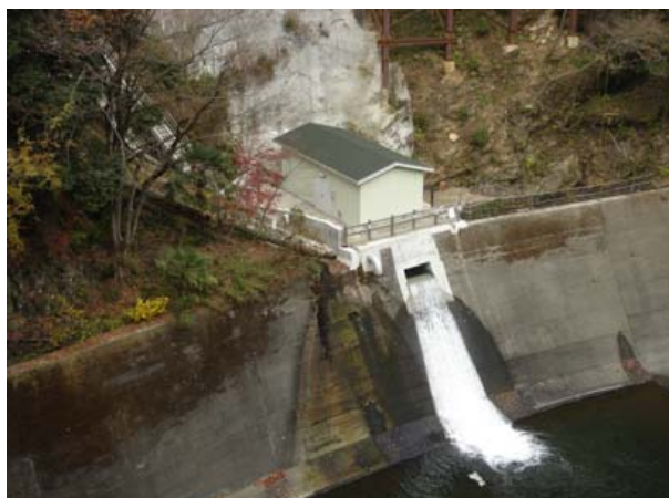
小水力発電（道志ダム発電所 出力50kW）
