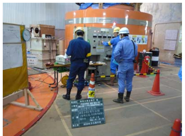
発電機の余寿命診断
