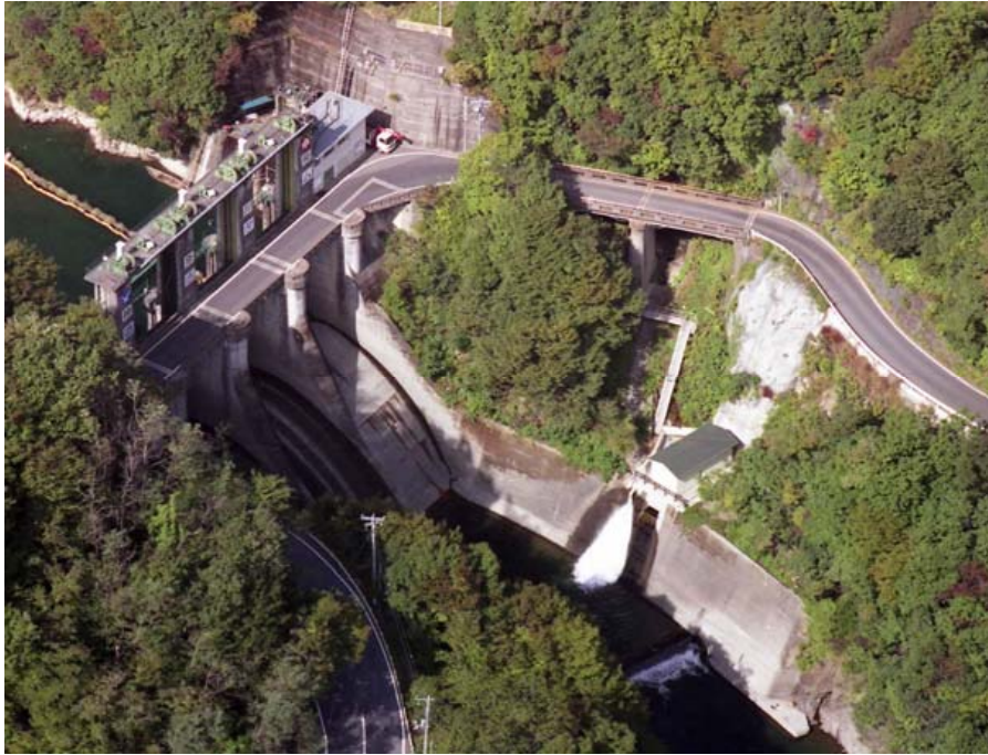
道志ダム・道志ダム発電所
