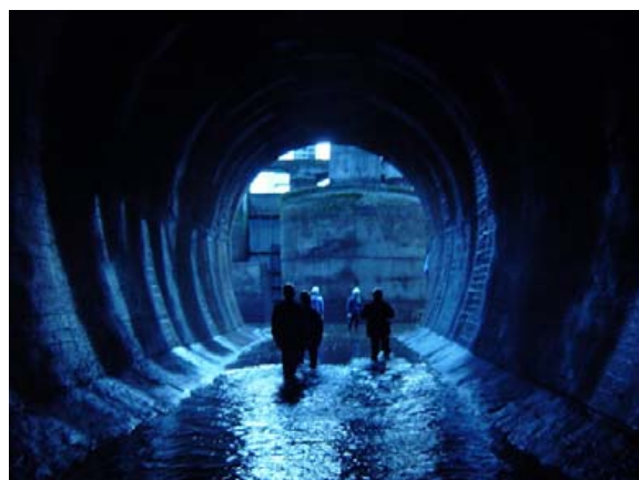
津久井導水路（出口）
