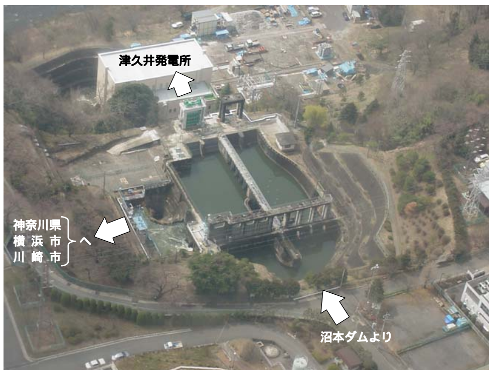
津久井分水池（昭和18年完成）
