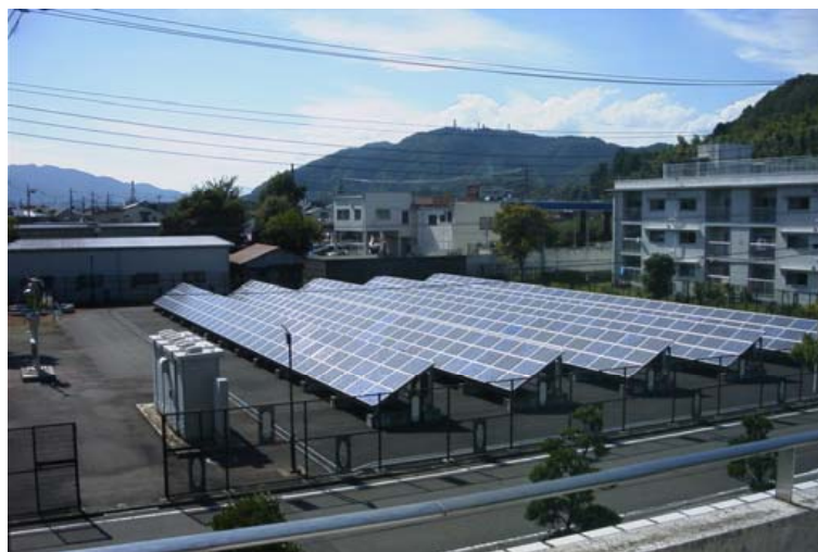
城山ソーラーガーデン（平成11年3月完成 50kW）
