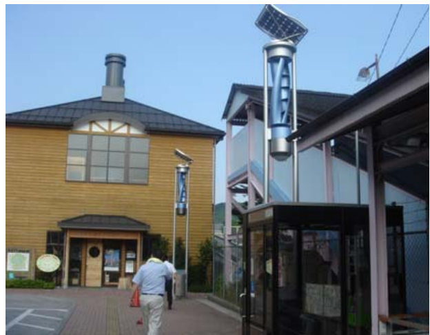
山北駅前の太陽光・風力発電併用型街路灯（山北町）
