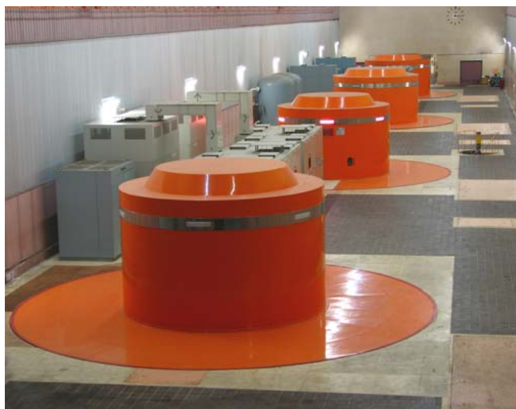
城山発電所（公営電気事業で最大規模 25 万 kW） （奥から 1・2・3・4 号機）
