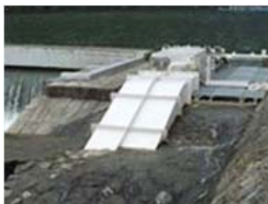
設置事例（京都市）
