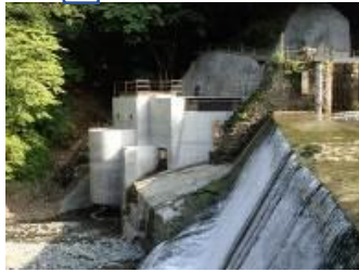
早戸川発電所
