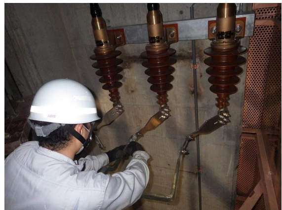
水力発電所の劣化診断（城山発電所）
