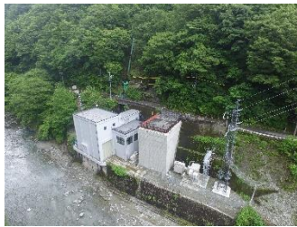
玄倉第1発電所
