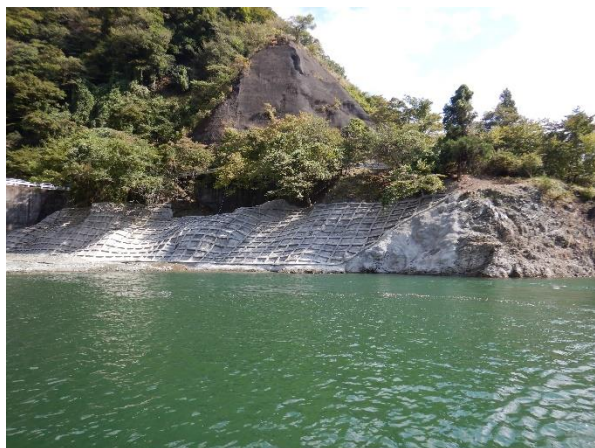
三保貯水池の崩落防止対策
