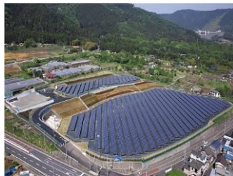
愛川太陽光発電所
