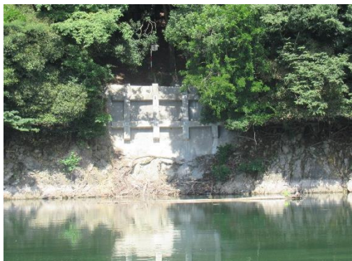
城山貯水池の崩落防止対策
