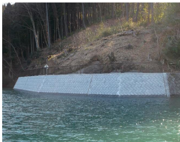
相模貯水池の崩落防止対策
