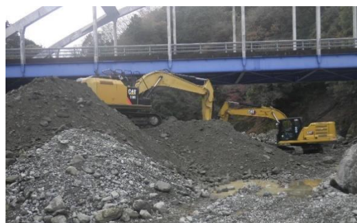
道志調整池のしゅんせつ作業 (バックホウによる陸上からの掘削作業)
