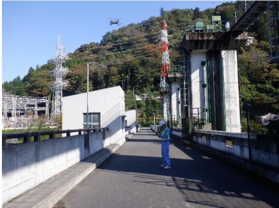
ドローンによるダムの点検・調査
