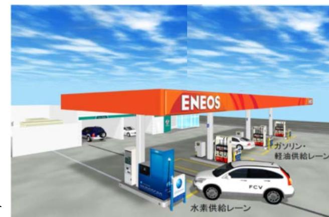
ガソリンスタンド一体型水素ステーション (海老名中央水素ステーションのイメージ)
