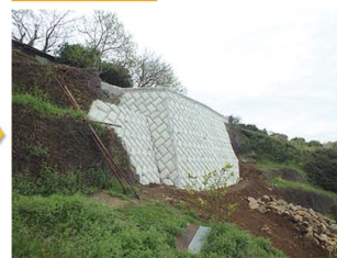
復旧し機能回復した農道
