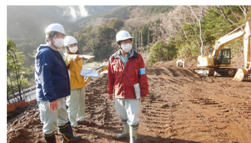
施工状況の把握・受注者との協議
