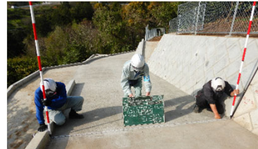
完成検査の実施
