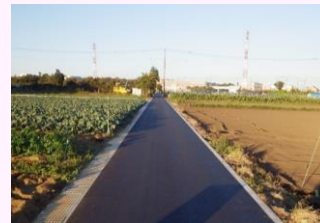
農村振興総合整備事業（舗装整備）
