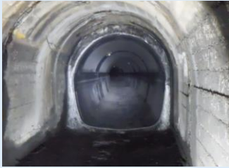
かんがい排水事業（水路トンネル）
