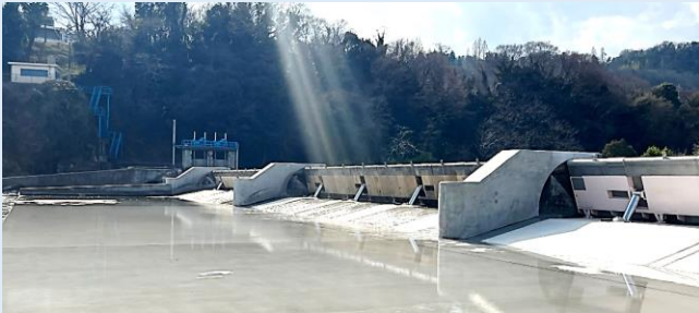
農業水利施設予防保全事業（頭首工の長寿命化対策）
