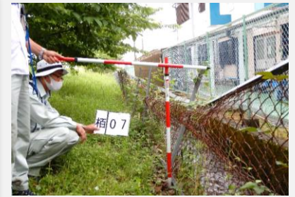
施設の点検・補修
