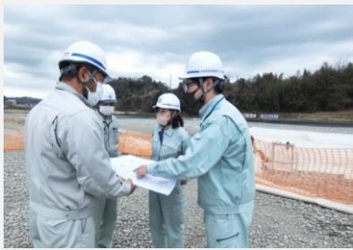
受注者と工事内容について協議
