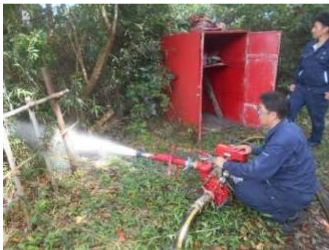
消防ポンプの点検・修理を実施
