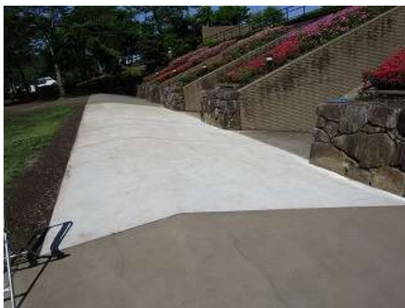
老朽化した施設の修繕（漕艇場前のコンクリート敷設）
