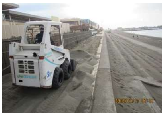
スキッドステアローダーによる堆砂除去作業
