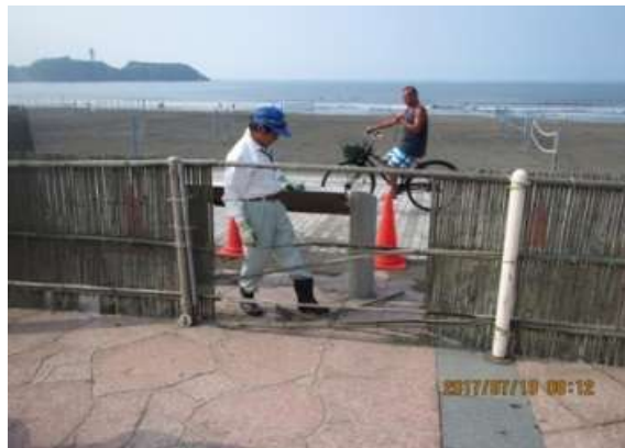
小破修繕や落書き消しなどを徹底し施設の修繕・美化に努めている
