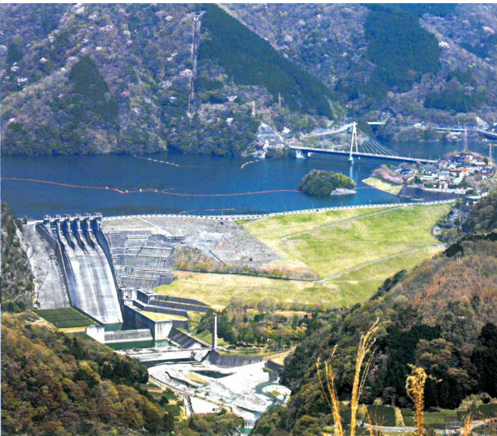
下流側から見た三保ダム
