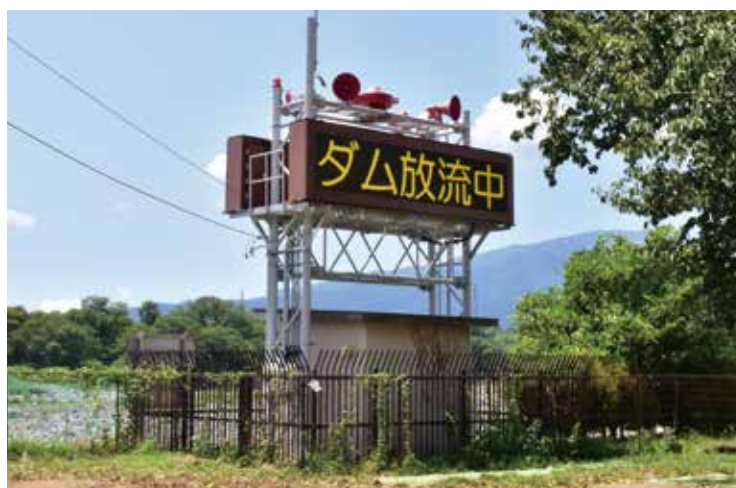
大口橋放流警報所
