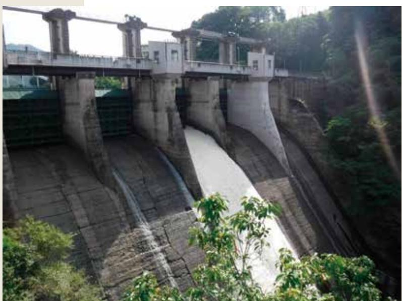
完成から70年以上が経過した相模ダムは、放流施設等の老朽化や、ダム下流の河道の浸食が進んでいることから、令和元年度から新たに「相模ダムリニューアル事業」として、老朽化したダム放流施設の更新とダム下流の護岸工・護床工等の整備に向けた取組みを進めています。
