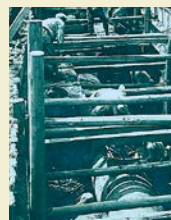
水道管をうめる
