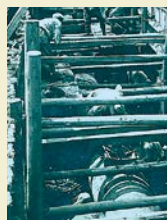
水道管をうめる
