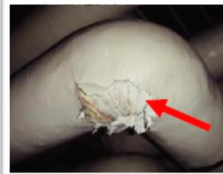
石綿含有断熱材、 保温材、耐火被覆 材(レベル2)
