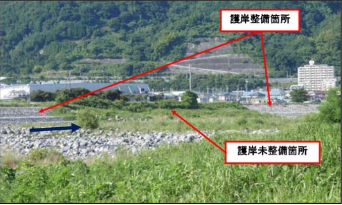
整備箇所（新大口橋下流左岸）
