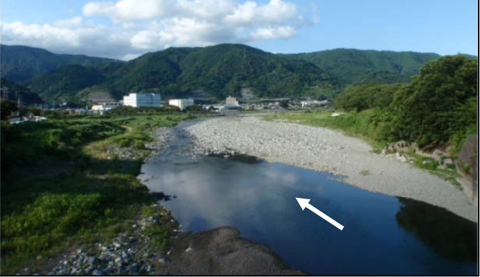
評価対象区間最上流（新大口橋下流）
