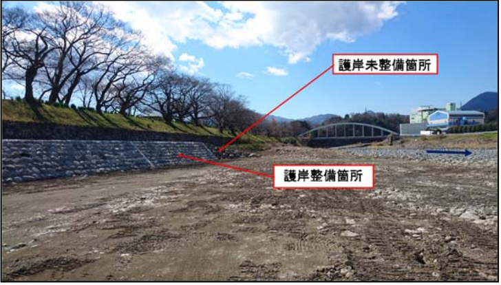
整備箇所（新大口橋下流右岸）
