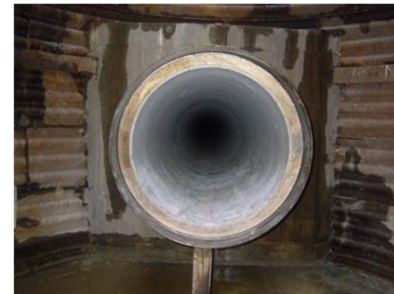
箱根小田原幹線 幹線管渠の整備（1-2工区：推進工φ800）
