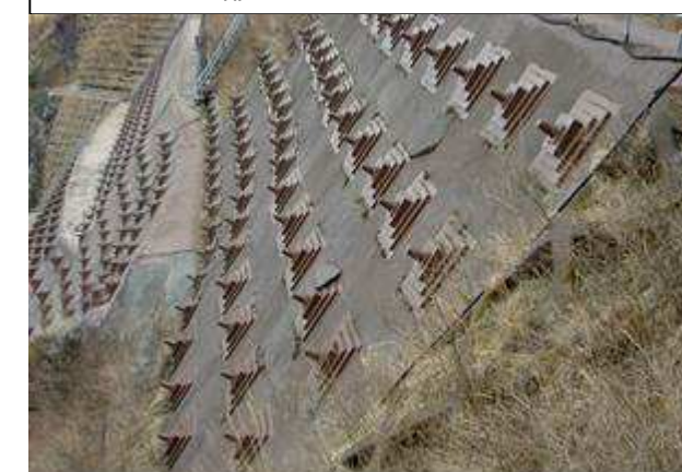
上部ブロックのアンカー工
