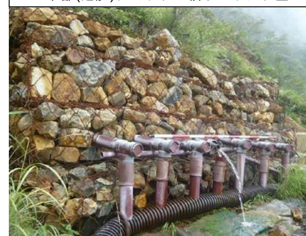
下部(追加)ブロックの横ボーリング工
