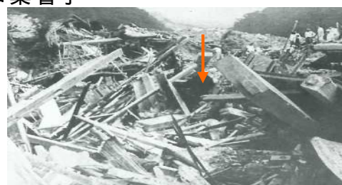
道了尊別院損壊(災害後)
