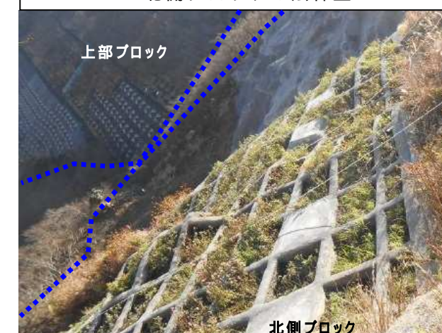
北側ブロックの法枠工
