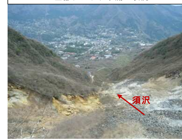
上部ブロック下流の状況
