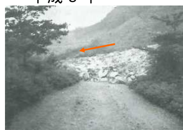
道路を閉塞した土石流(災害後)
