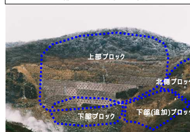
上部ブロック周辺の状況
