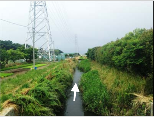
流橋（評価対象区間最上流）より下流側
