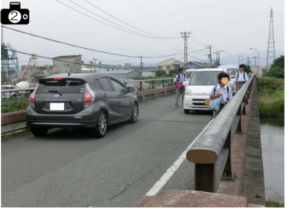
狩川に架かる橋梁(市道)の状況
