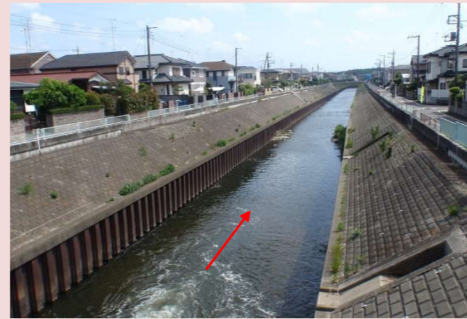
改修前の状況（鹿島橋付近）
