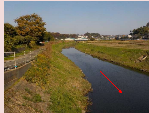
改修前の状況（村野橋上流付近）
