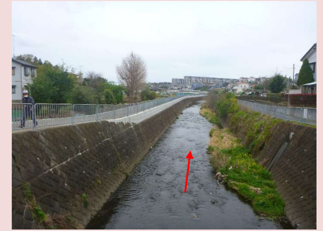
改修後（堤防高上げ）の状況（弥生橋下流付近）
