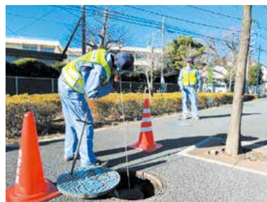
漏水調査の様子
