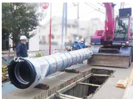
管路更新工事の様子
