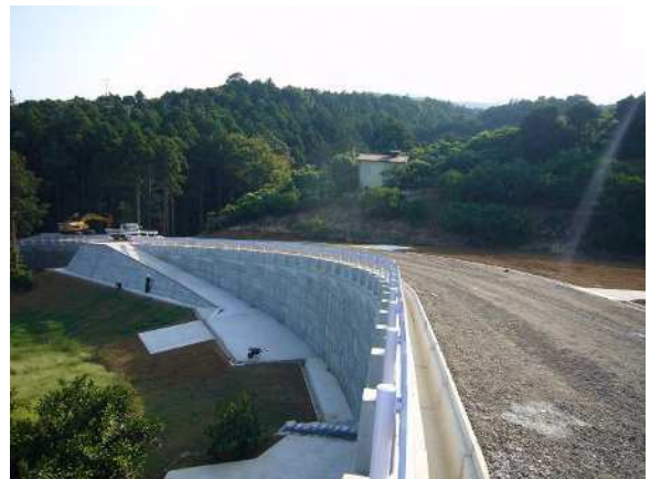
工事完了（舗装前）
