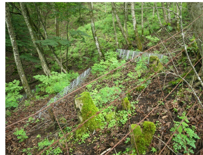
金網筋工がリター捕獲により表土流出を抑止して 林床植生が生育(マツカゼソウ) 不嗜好性
