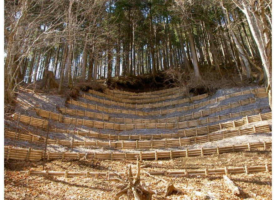
土壌流出防止対策(丸太柵)を実施
