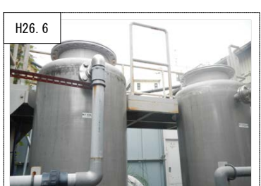
H26. 6 ⑦地下水保全対策 有機塩素系化学物質により汚染された地下水を施設の装置に通すことにより水質浄化を図った。(秦野市)
