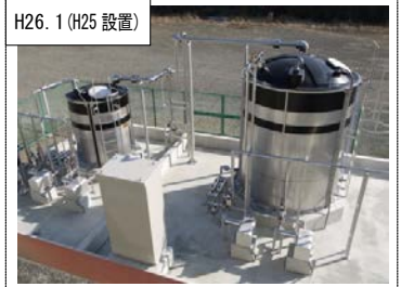
H26. 1 (H25 設置) ⑩相模川水系上流域対策 山梨県内の下水処理場に新たに設置したリンを取り除くための設備を移動した。(山梨県桂川清流センター)
