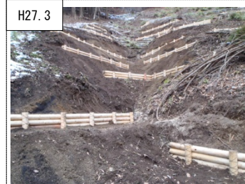
H27. 3 ③溪畔林整備 土壌流出が発生している、あるいは発生しそうな箇所土壤保全工を実施した。(山北町仲の沢)
