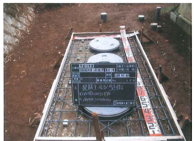
一般家庭への浄化槽設置（5人槽）
