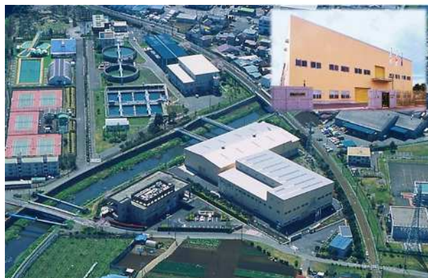
【寒川浄水場排水処理施設】
