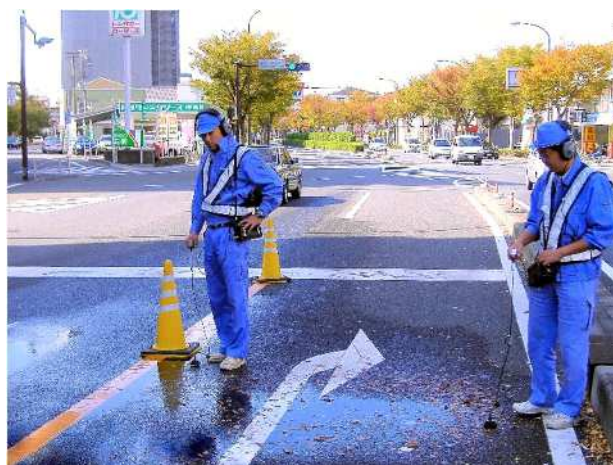
【漏水調査の様子】
