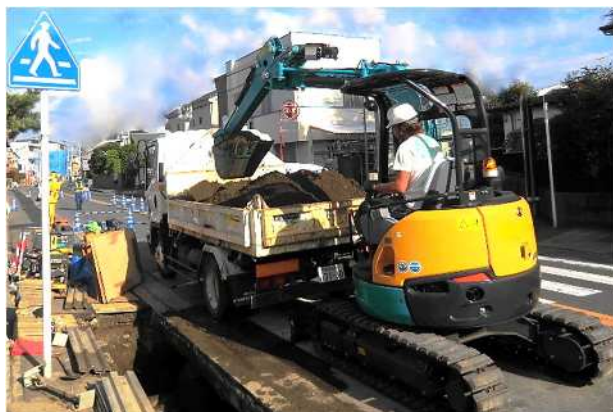
【水道管埋設状況】
