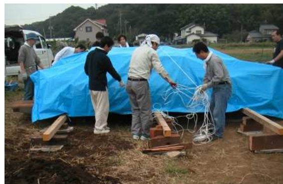
市民活動の様子/旧三井別邸(大磯町) 解体保存した部材の養生作業
