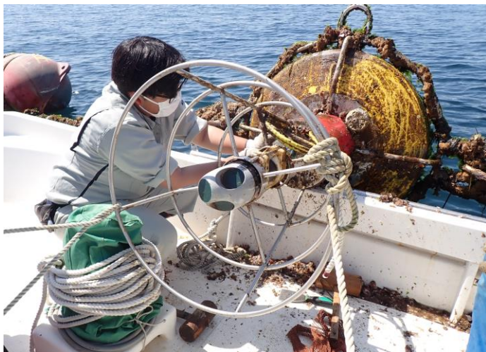
ブイに取り付けてある防食亜鉛板の交換作業
