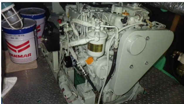
補機関（発電機）
