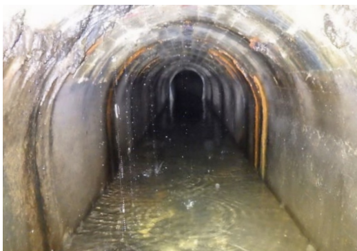
老朽化した水路トンネル
