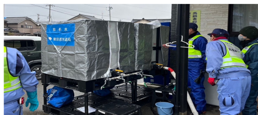
能登半島地震支援(仮設受水槽)
