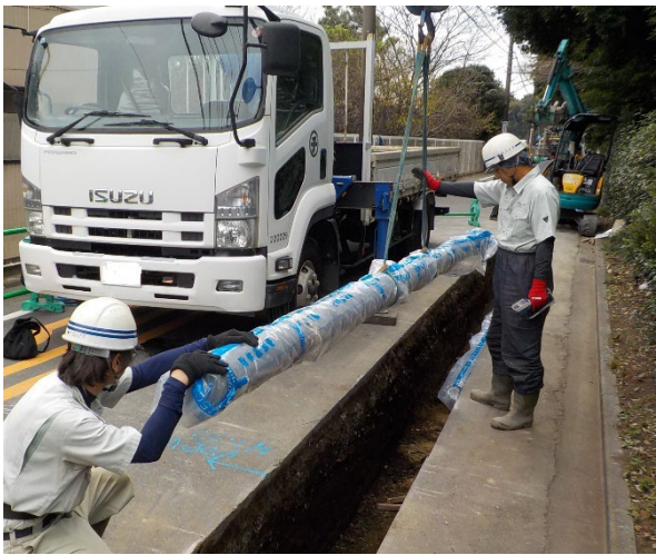
铸铁管の更新の様子
