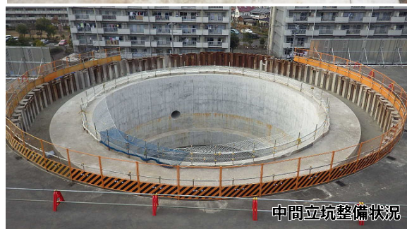
発進立坑整備状況
