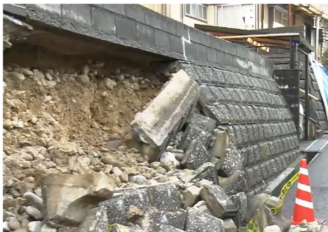
(令和6年能登半島地震により崩壊した宅地擁壁)
