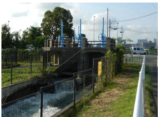
水門の遠隔電動操作化
