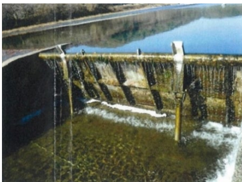
老朽化した頭首工の補修
