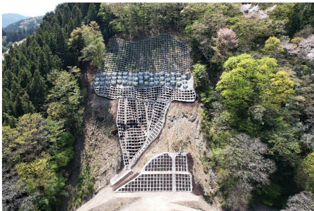
治山施設（山腹工）
