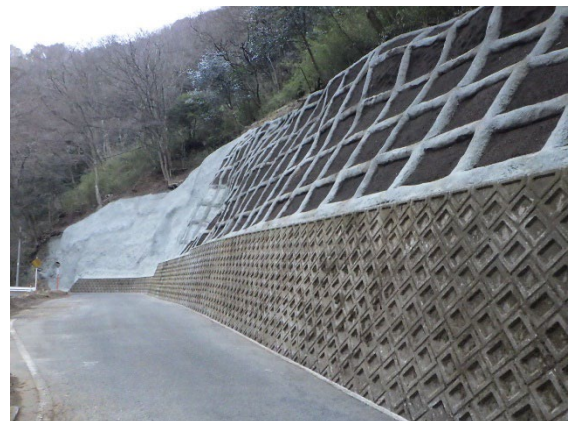
林道施設（法面保護工）
