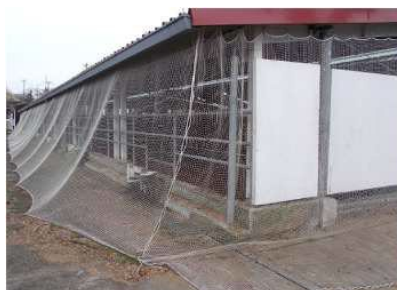
防鳥ネットの補修
