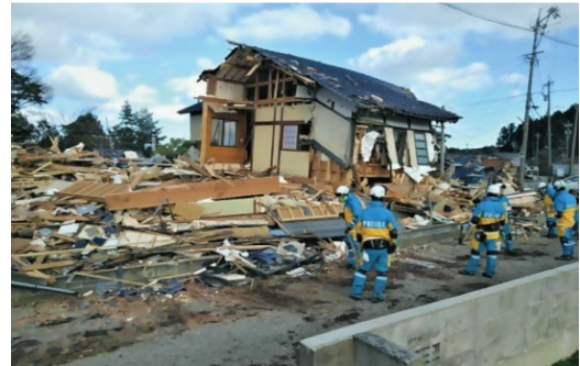
<能登半島地震での被害> (石川県珠洲市)
