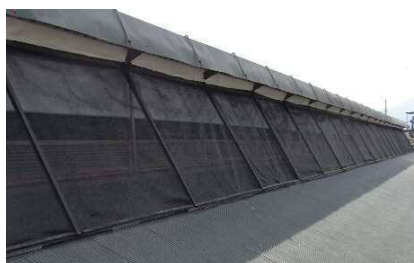
写真1 豚舎開口部の遮光ネット設置状況
