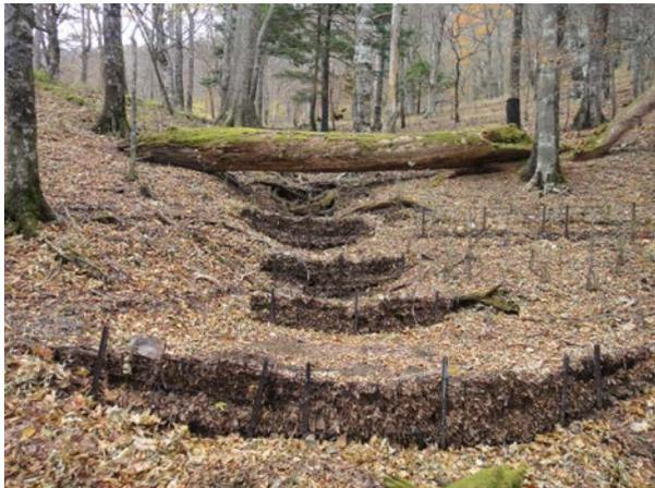
土壤保全対策工事で設置した金網筋工の設置後 5 年の状況。侵食箇所には落葉落枝が堆積し、森林土壌の流亡を抑えている状況がうかがえる。
