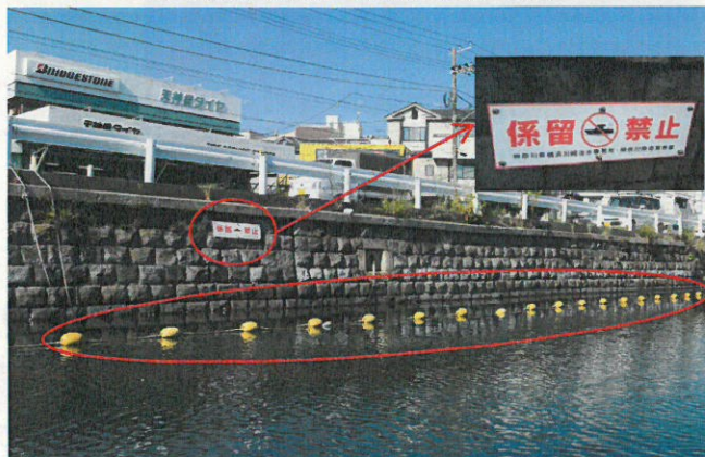
⑥ 撤去後の対応 (フロート・看板の設置)
