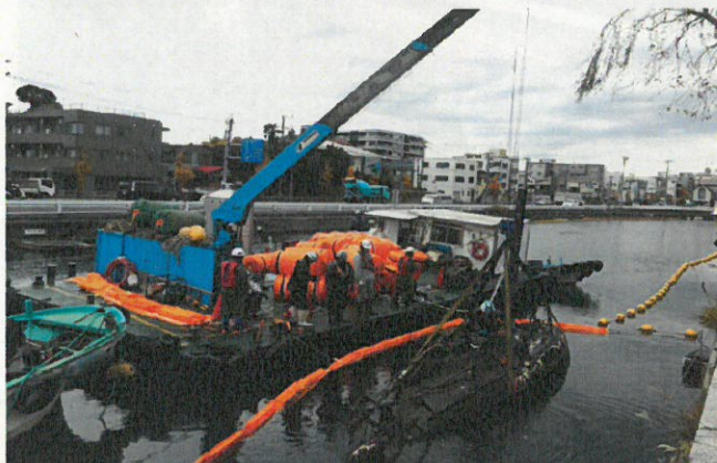
④ 行政代執行 (沈船の引上げ)
