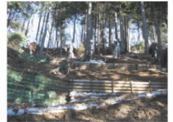
丸太柵で土砂が流れ出すのを防ぐ
